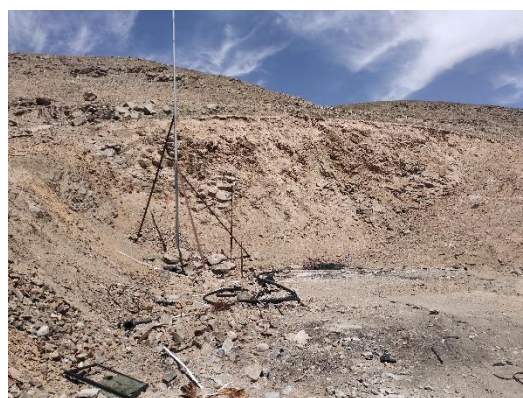
图 3-8 Q_6 不稳定斜坡
