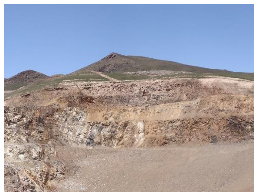
图 3-10 Q_8 不稳定斜坡
