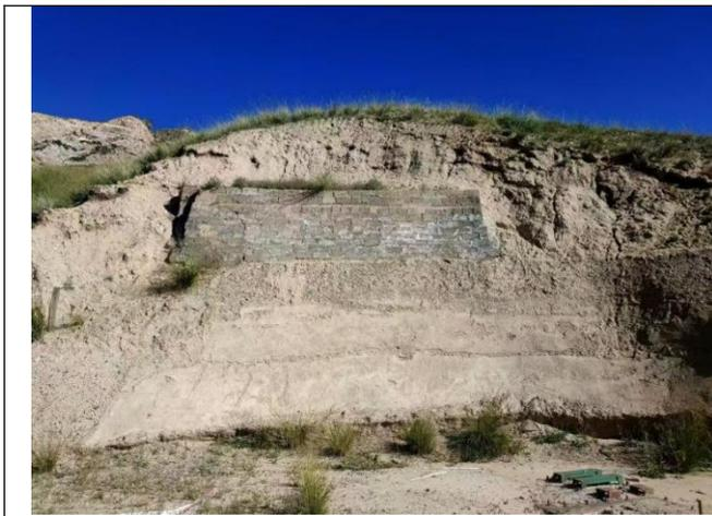
照片10 浆砌混凝土块挡墙 (下方为SJ6-1, 已回填)
