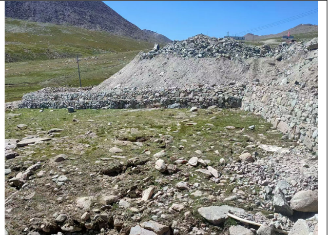
照片2.7.10 PD5工业场地废石堆场下部拦挡墙
