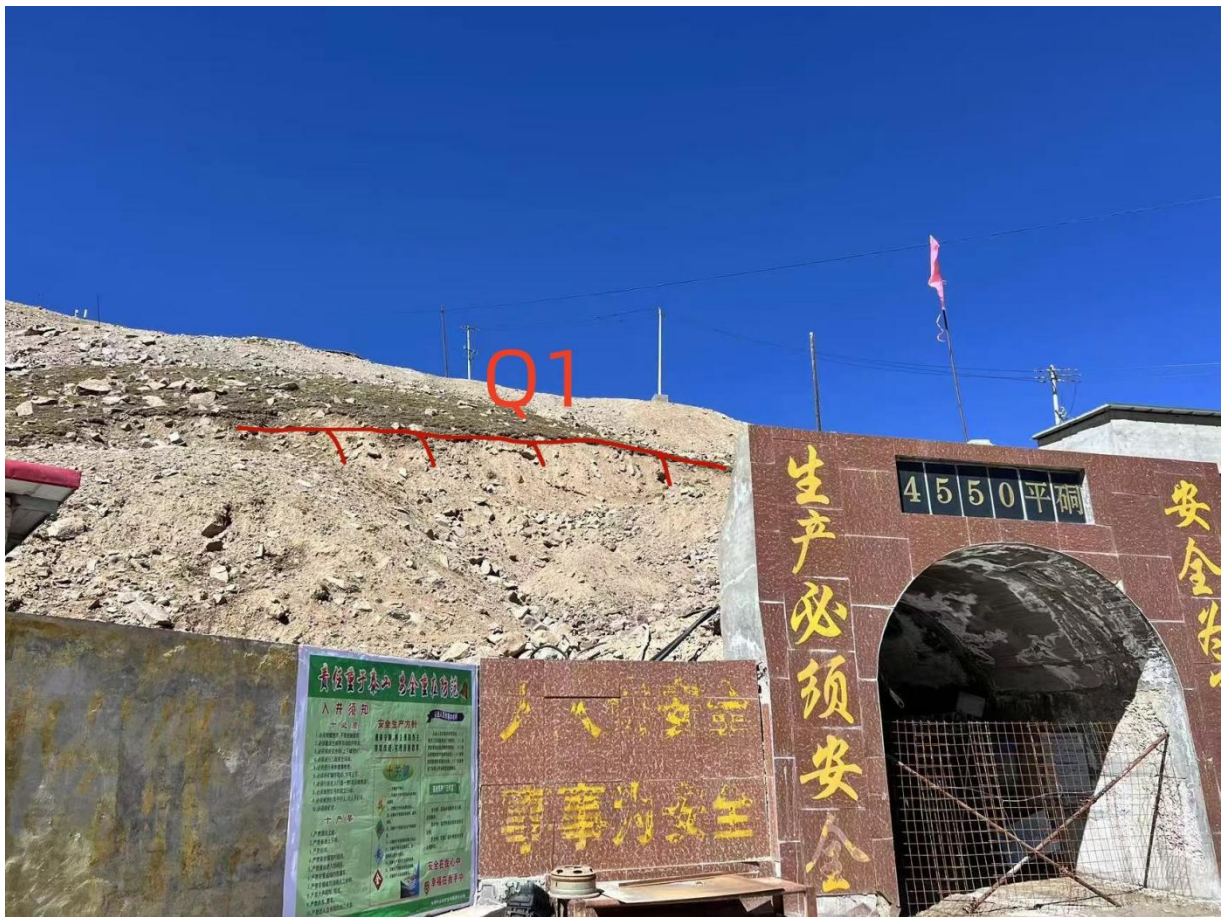
图3.2.1 不稳定边坡 Q_1 照片
