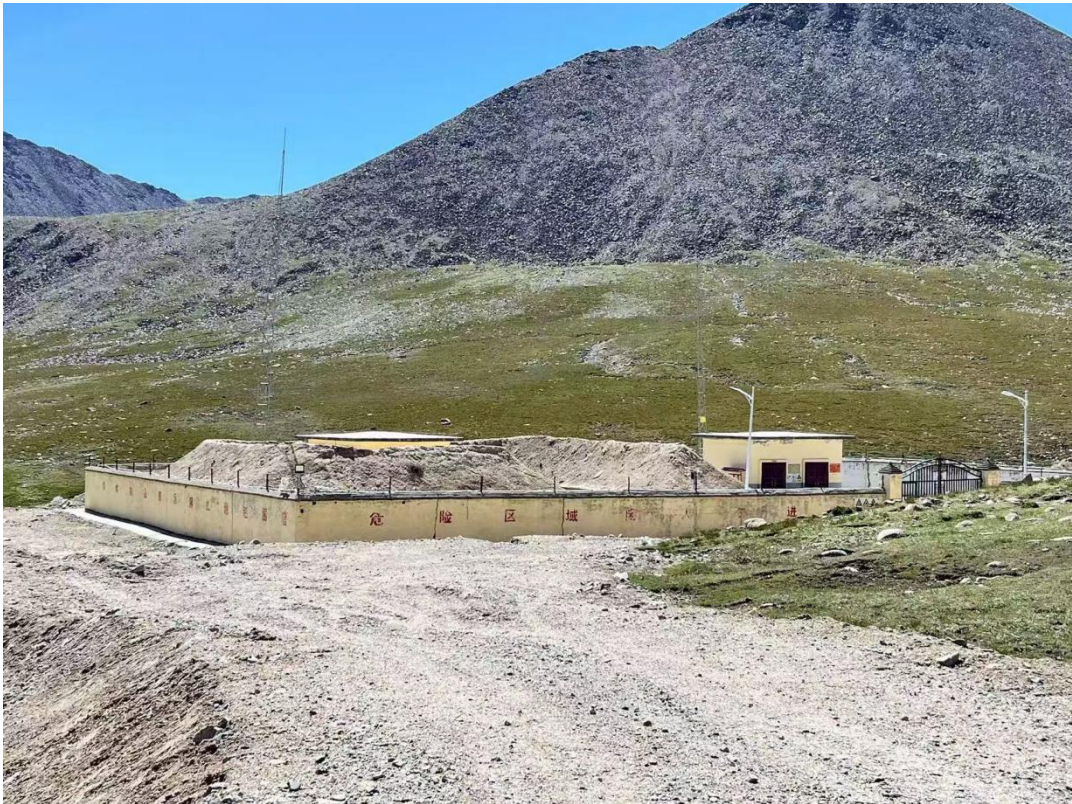
图1.3.4 爆破器材库照片
