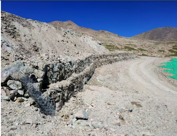
照片2.7.9 PD4工业场地废石堆场下部拦挡墙
