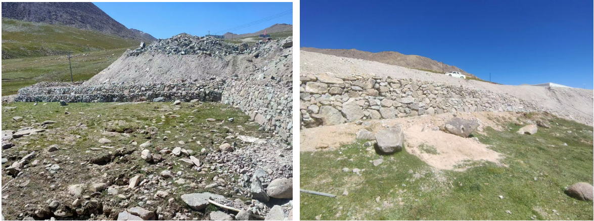
图1.3.8 区域拦挡墙照片（左图为PD5工业场地下部，右图为工业场地至新建行政生活区道路下部）
