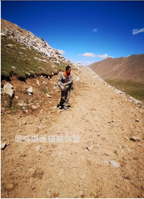
照片2.7.7 废弃道路植被恢复
