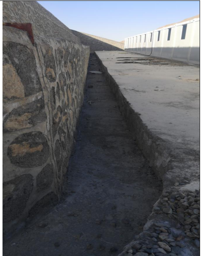
照片2.7.8 新建行政生活区旁防洪排水沟工程
