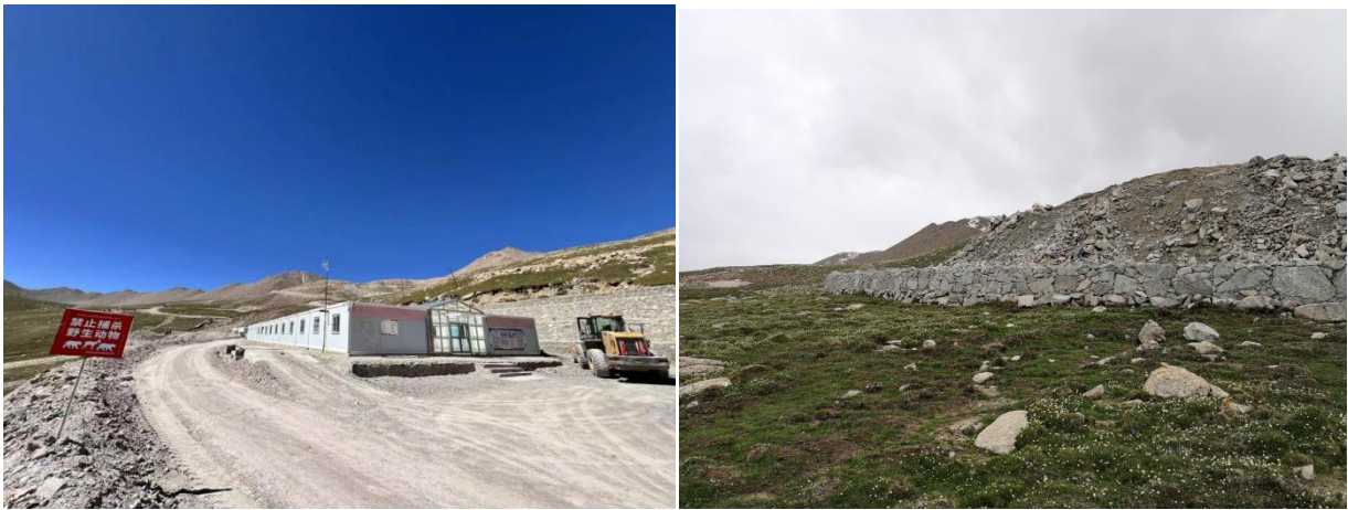
图1.3.5 新建行政生活区照片（左图左侧为采矿道路1，右图东侧底部为钢丝石笼拦挡墙）
