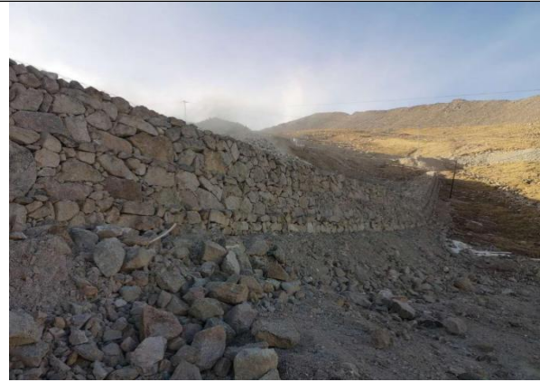
照片2.7.6 PD4废石堆场旁浆砌石拦挡墙建设
