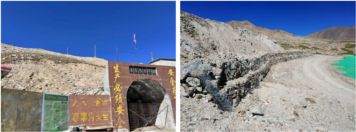
图1.3.1 PD4工业场地照片（左为硐口，右为废石堆场下侧拦挡墙）
