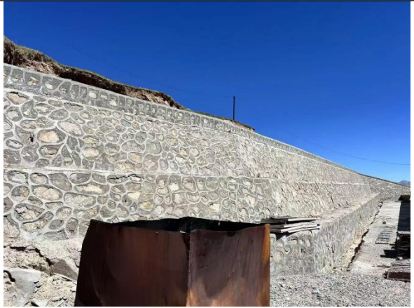
照片2.7.3 新建行政生活区旁浆砌石拦挡墙
