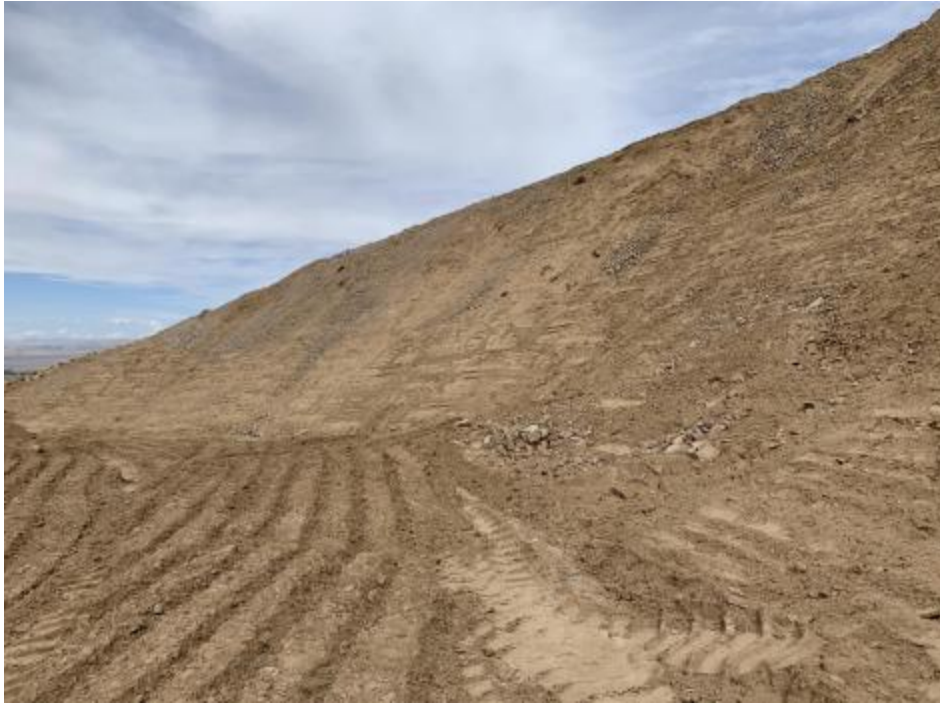
照片 2-7 治理后露天下凹采坑以全部填平（东侧）
