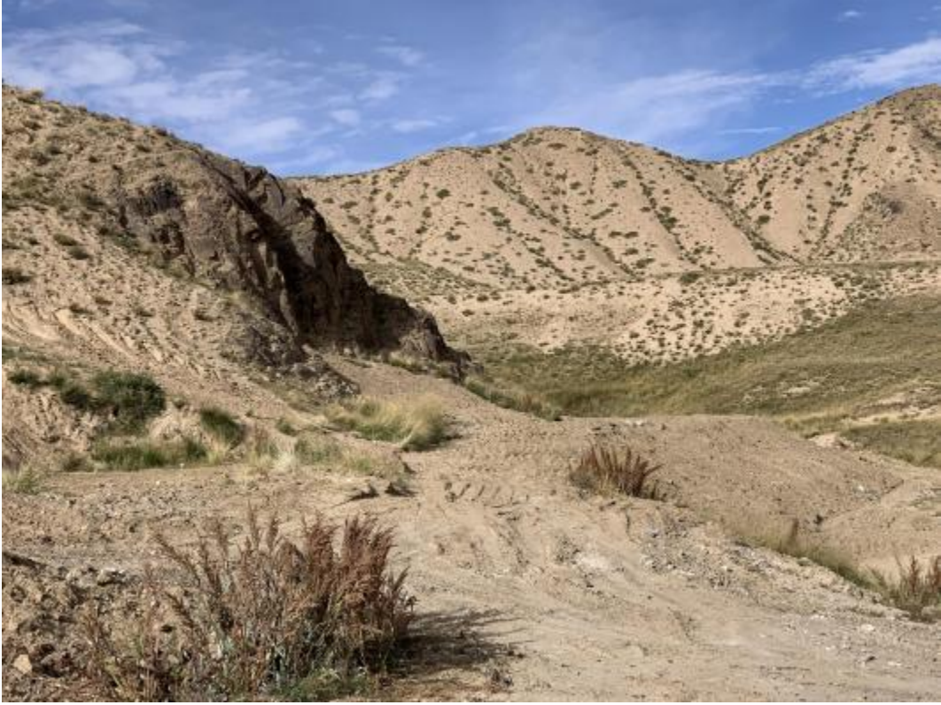
照片 2-9 治理后遗留的弃渣已被摊平覆盖
