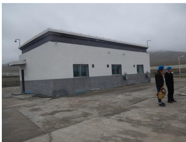
照片 1 水源地一期集水房
