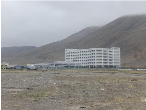
照片 11 二期生活区建筑物
