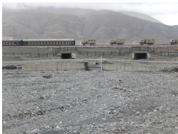
照片 20 过泥石流 ( N_1 ) 流通区的 矿山道路盖板涵、铁路涵洞
