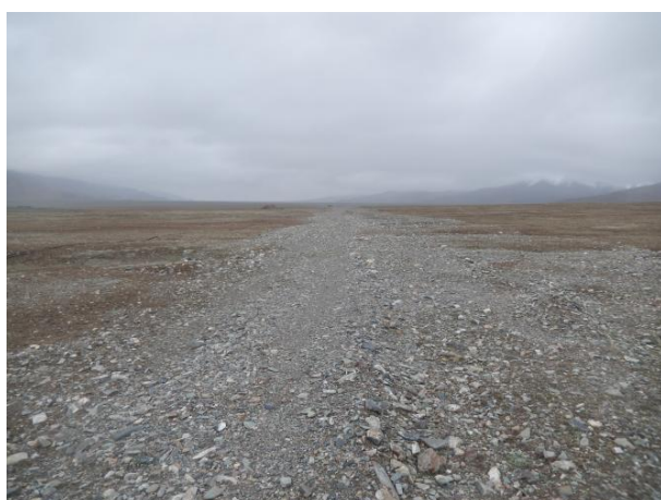
照片5 二期引水管线西段复垦现状
