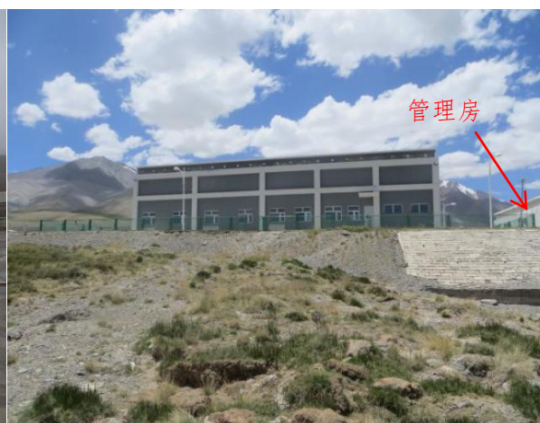
照片 2 水源地二期集水房及管理房
