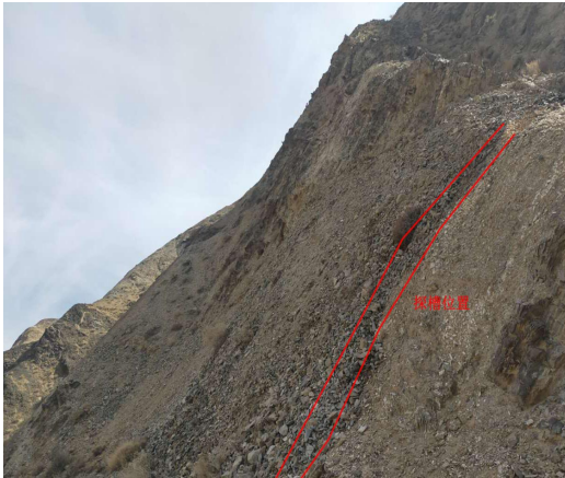
照片 1-3 已回填的探槽
