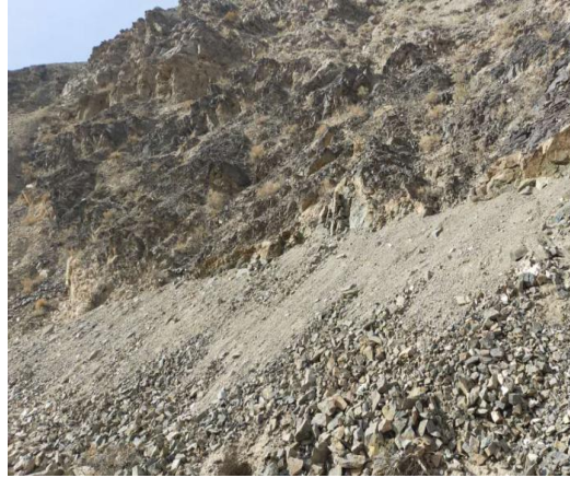
照片 1-2 已回填的探槽
