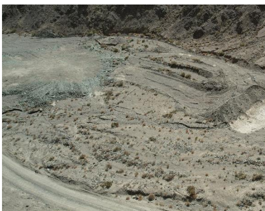
图1-10 场地平整时残留废石及砂堆堆
