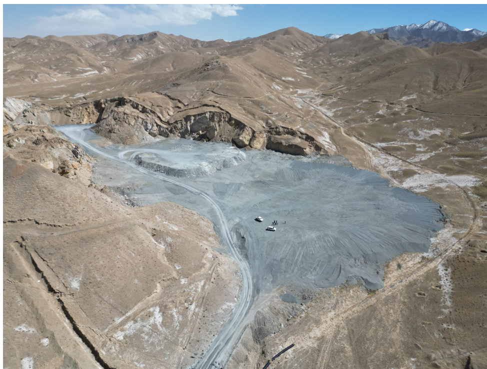
照片 3-1 采空塌陷坑现状
