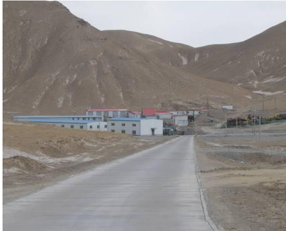
照片 1-5 矿山道路（水泥路面）
