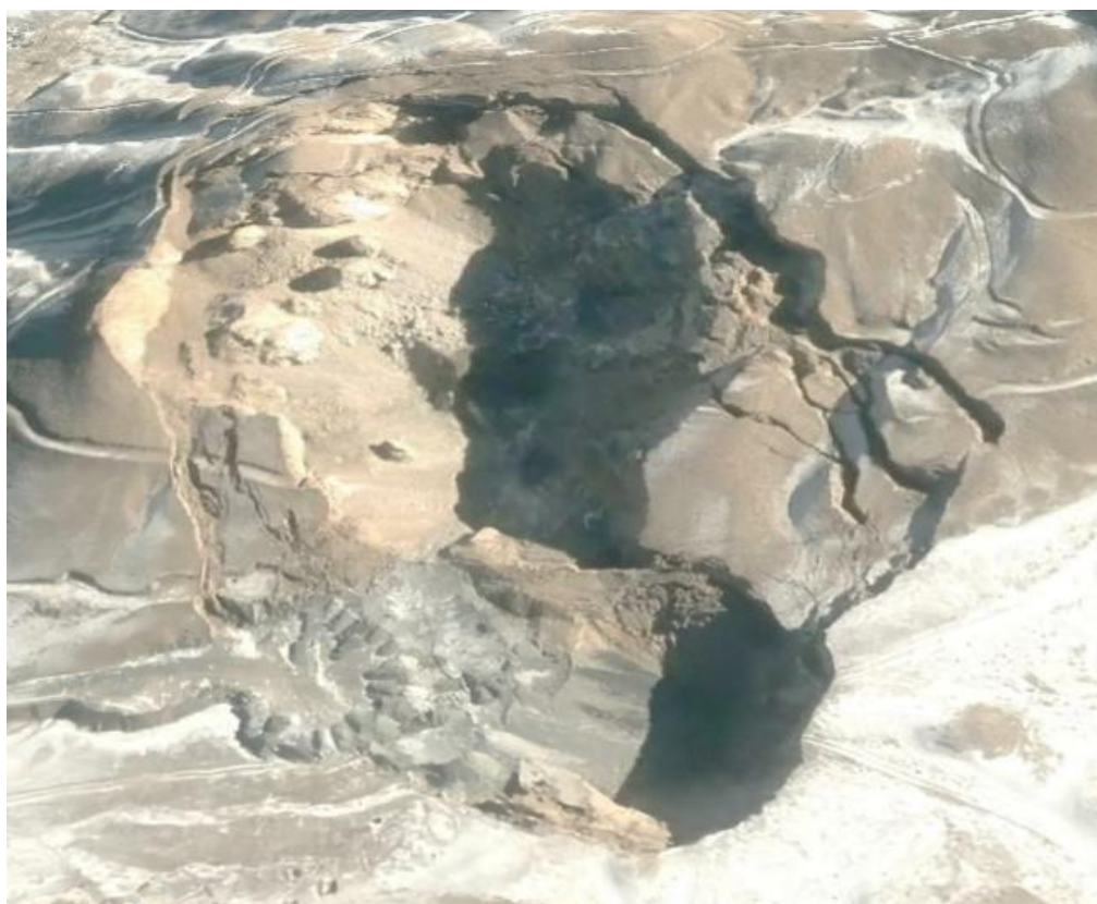
图 3-1 采空塌陷坑初期卫片
