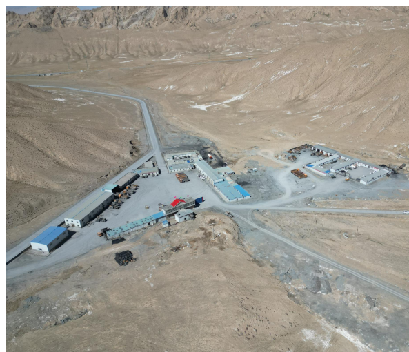
照片 1-2 斜坡道工业广场
