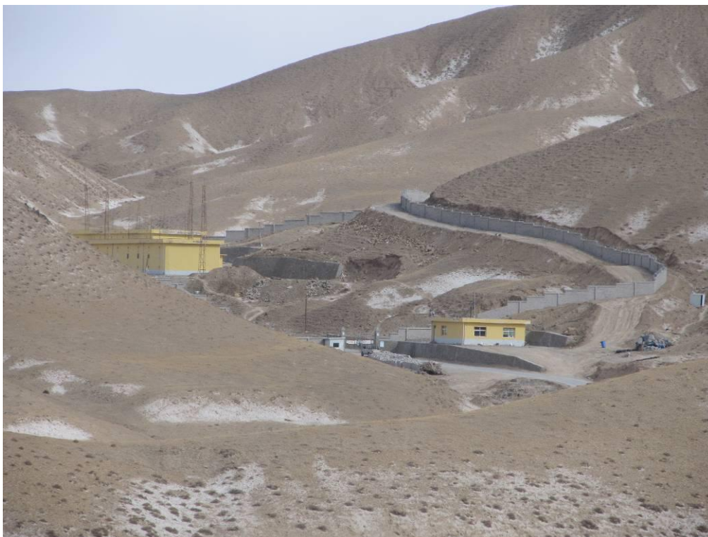
照片 1-4 爆破器材库
