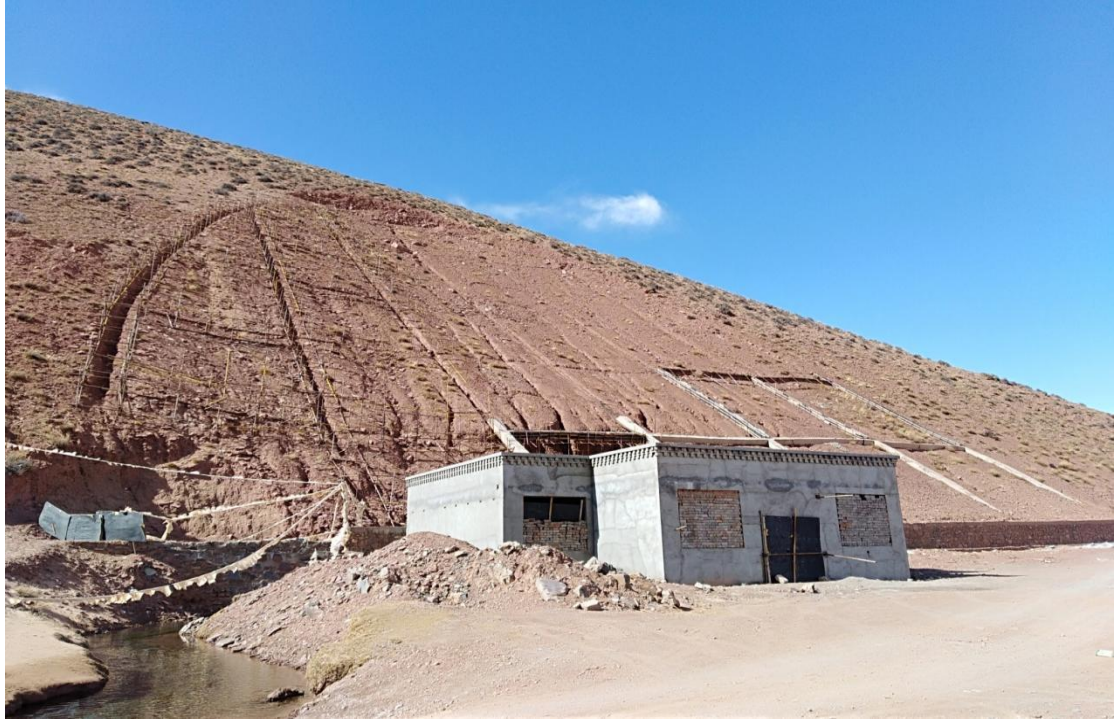
照片 1-1 水源井房
