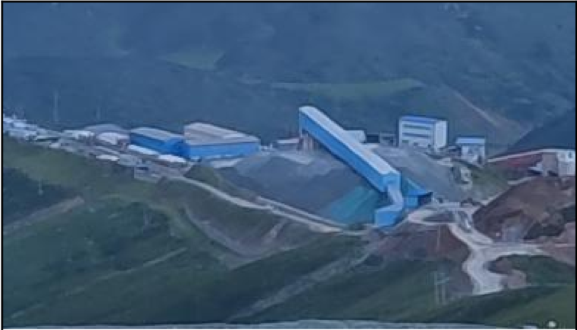
图 1-12 选矿厂、堆矿场
