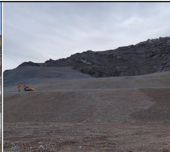
照片8 排土场-台阶清理
