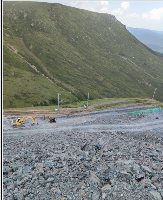
照片 11 排土场-挡土墙
