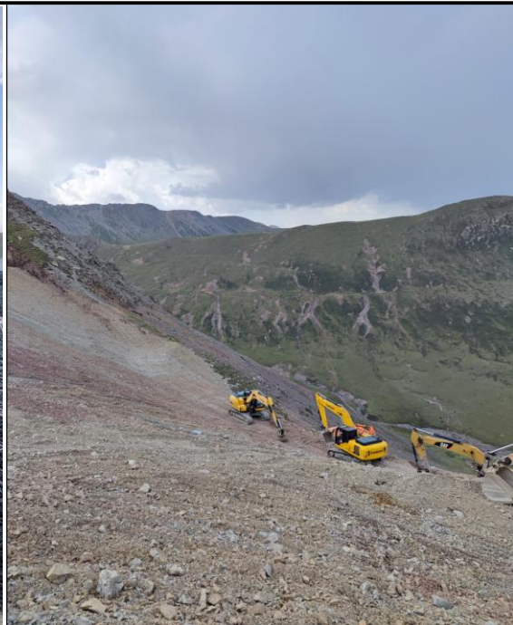
照片 10 排土场-边沟清理
