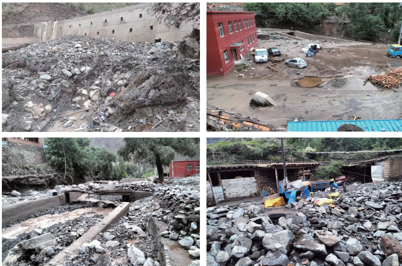
图 3 尖扎县当顺乡古浪堤沟泥石流
