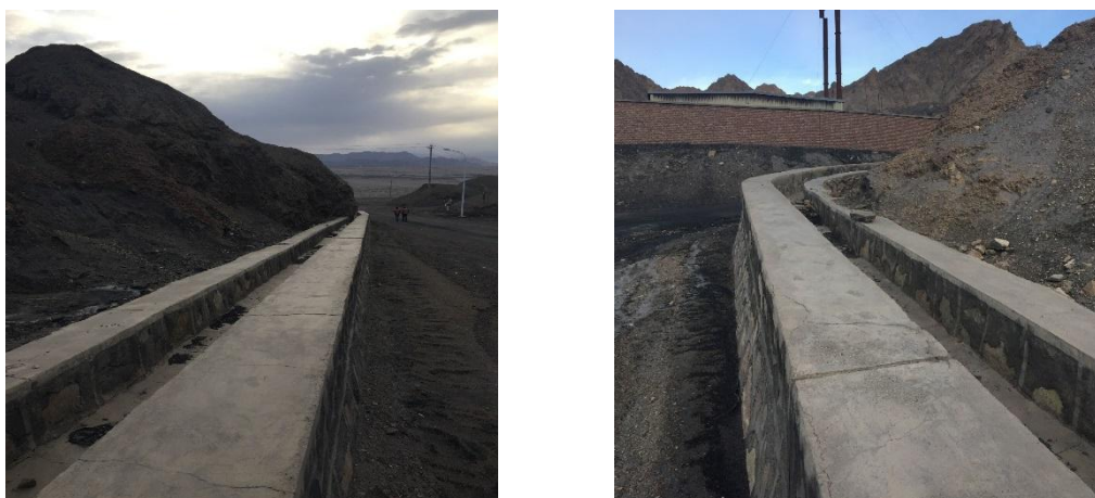
图 3-4 已建挡墙及截排水工程
