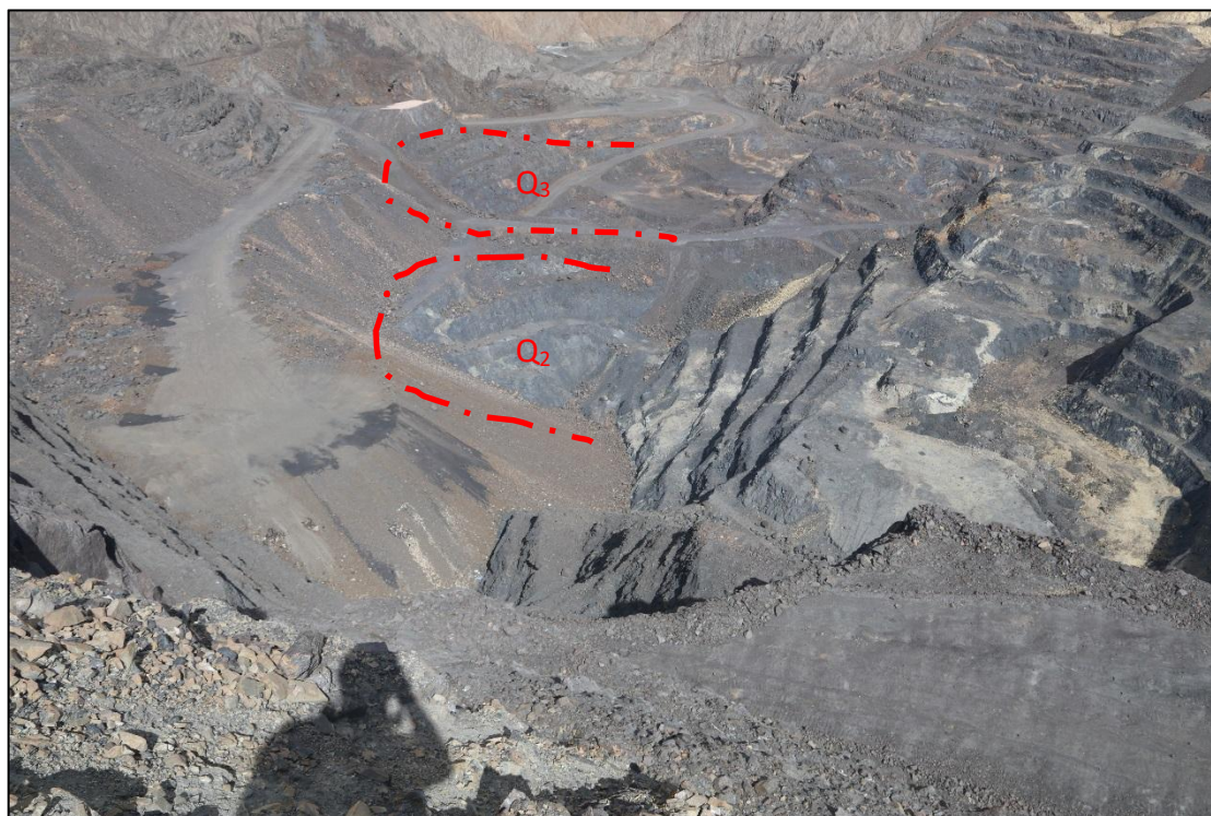
图 3-7 Q 2 、Q 3 不稳定斜坡全貌
