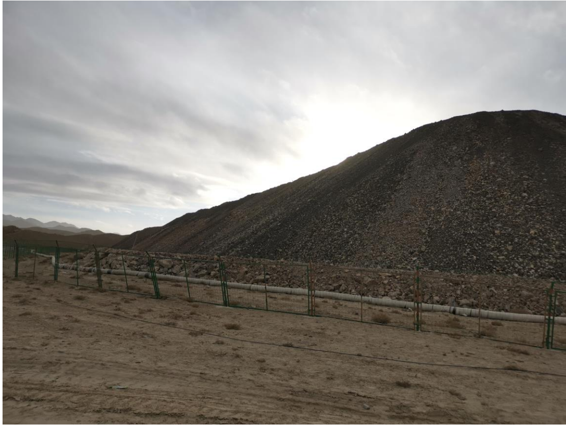
照片 6 排土场底部挡墙
