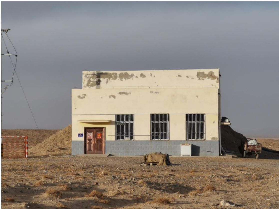
照片 15 加压泵房
