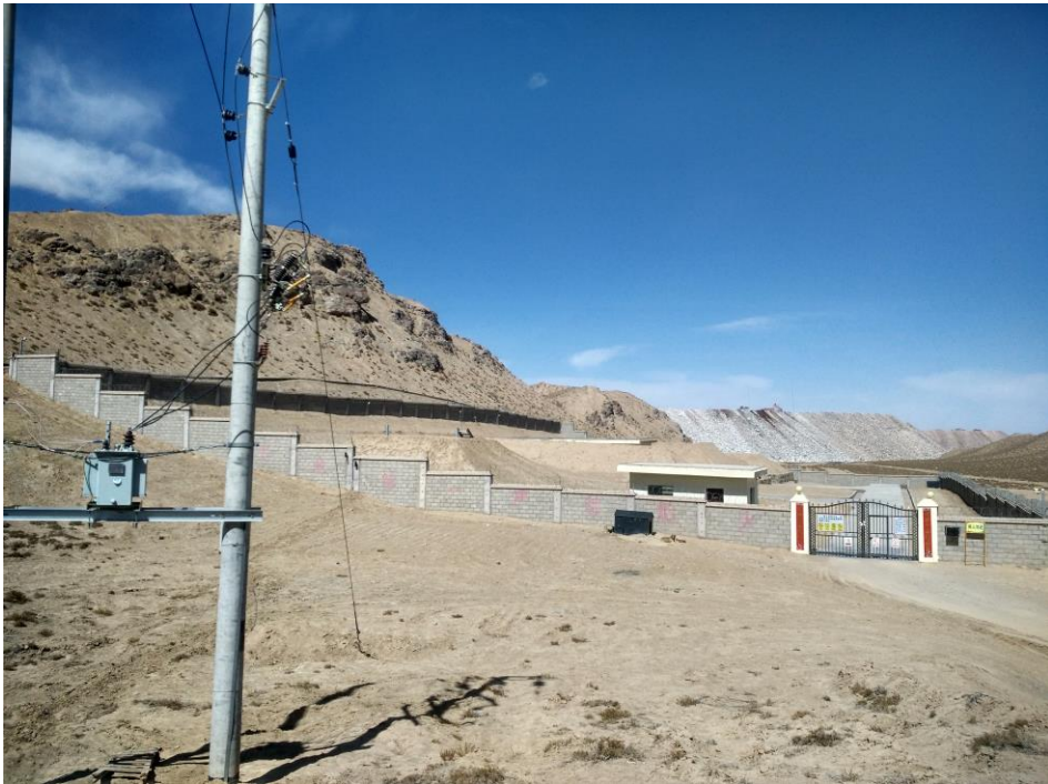
照片 11 爆破器材库
