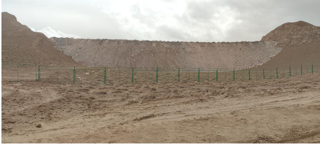
照片3 东排土场北侧斜坡下方设置的网围栏
