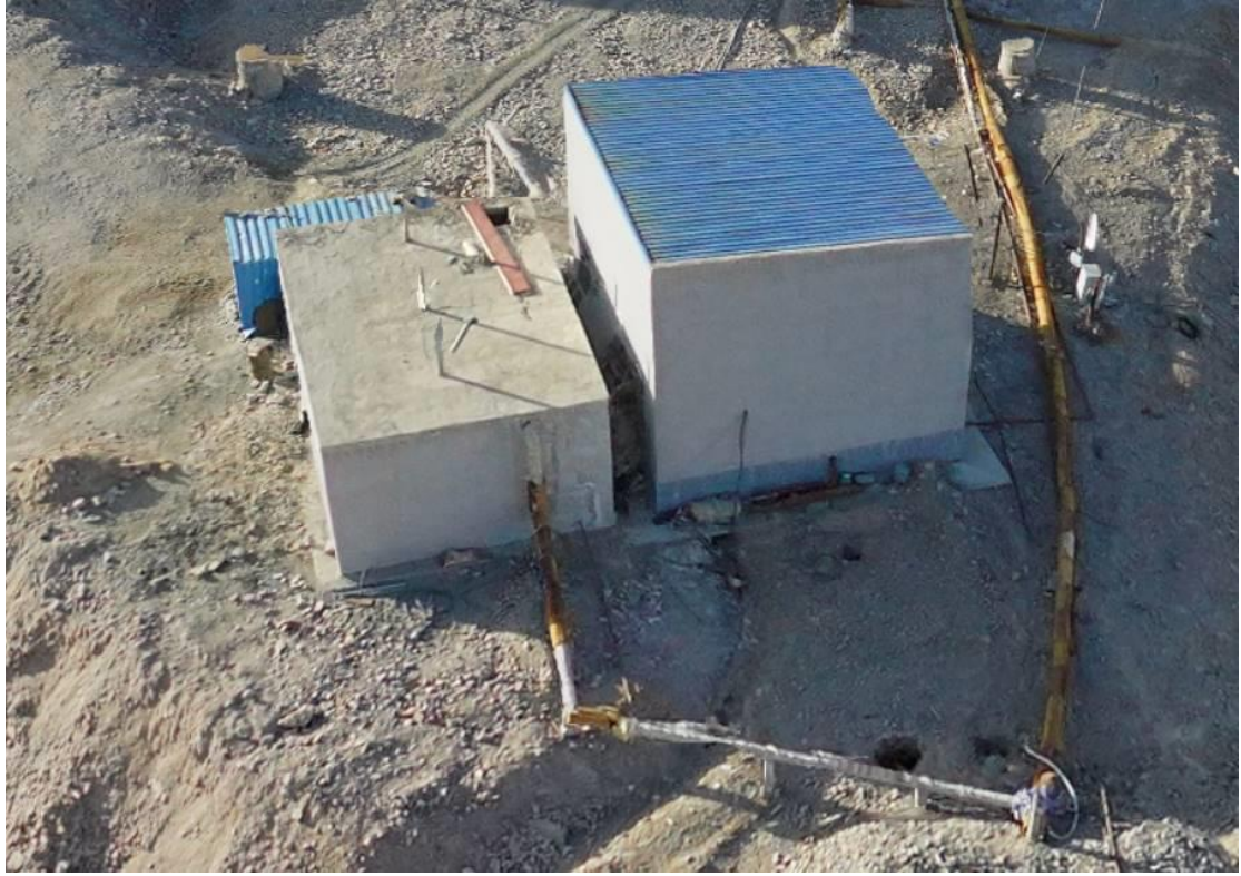
照片 14 高位水池
