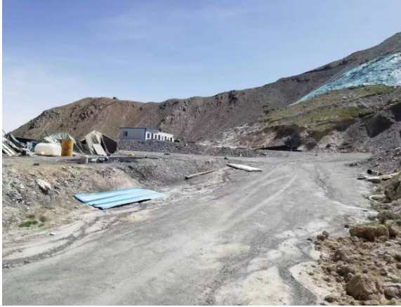
照片1-2 工业场地现状
