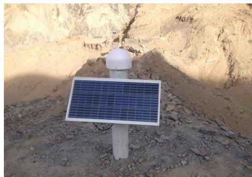
布置塌陷坑周边的 GNSS 位移自动监测仪
