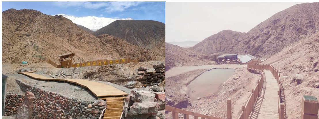
照片 1.8 临时道路
