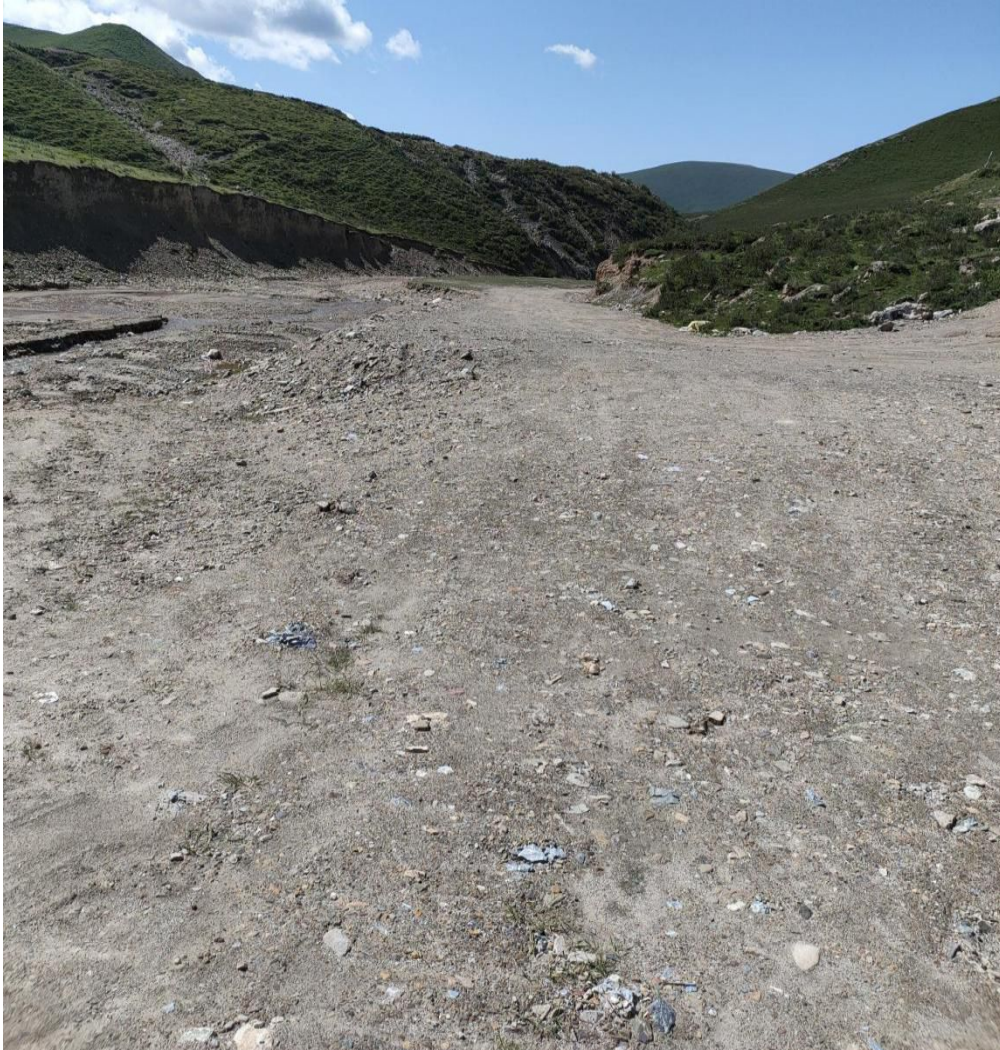
照片 1.1 矿区道路
