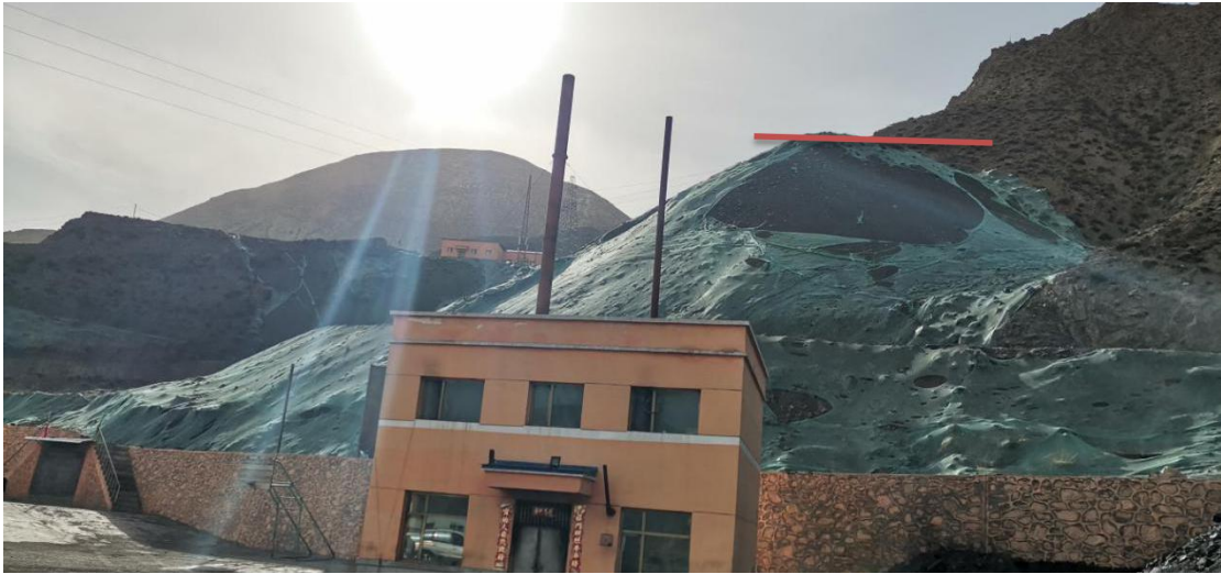
照片 3.2-2 不稳定斜坡 Q 2
