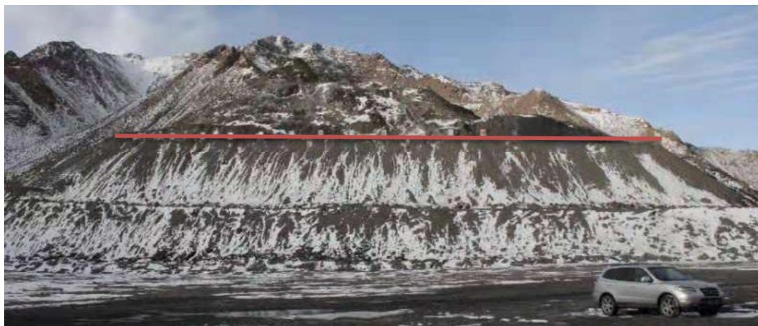
照片 3.2-3 不稳定斜坡 Q 3
