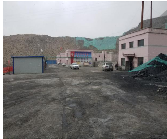
照片 3.3-2 生活区已损毁土地情况
