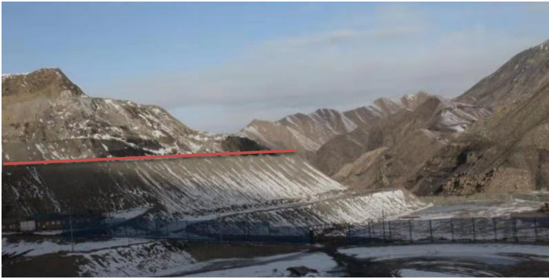
照片 3.2-5 不稳定斜坡 Q 5
