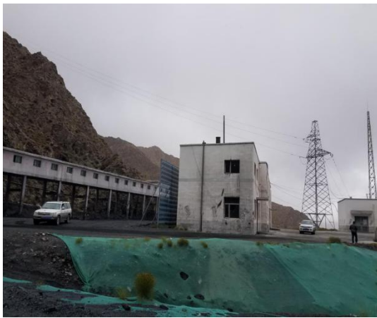
照片 3.3-1 主井工业场地已损毁土地情况
