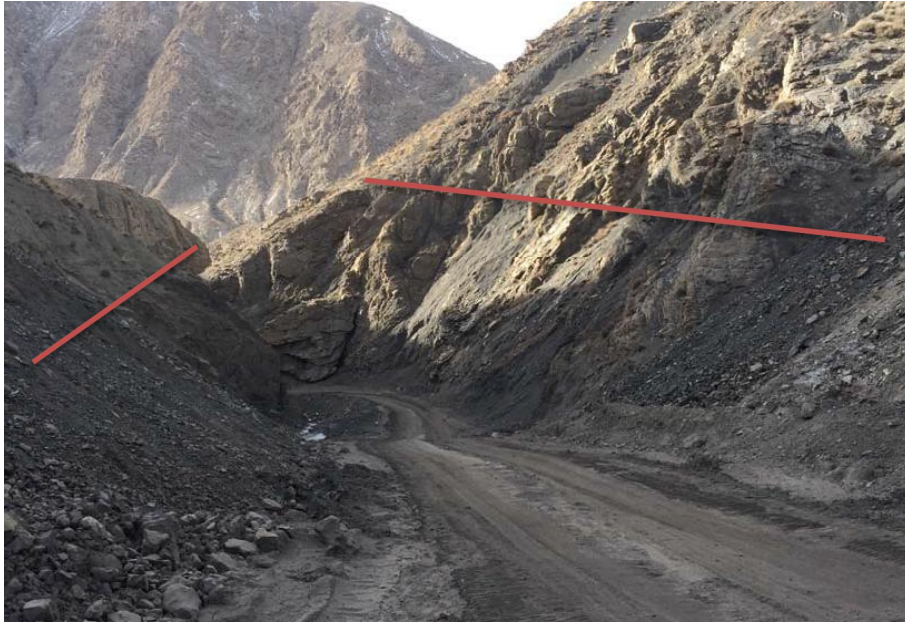
照片 3.2-4 不稳定斜坡 Q 4
