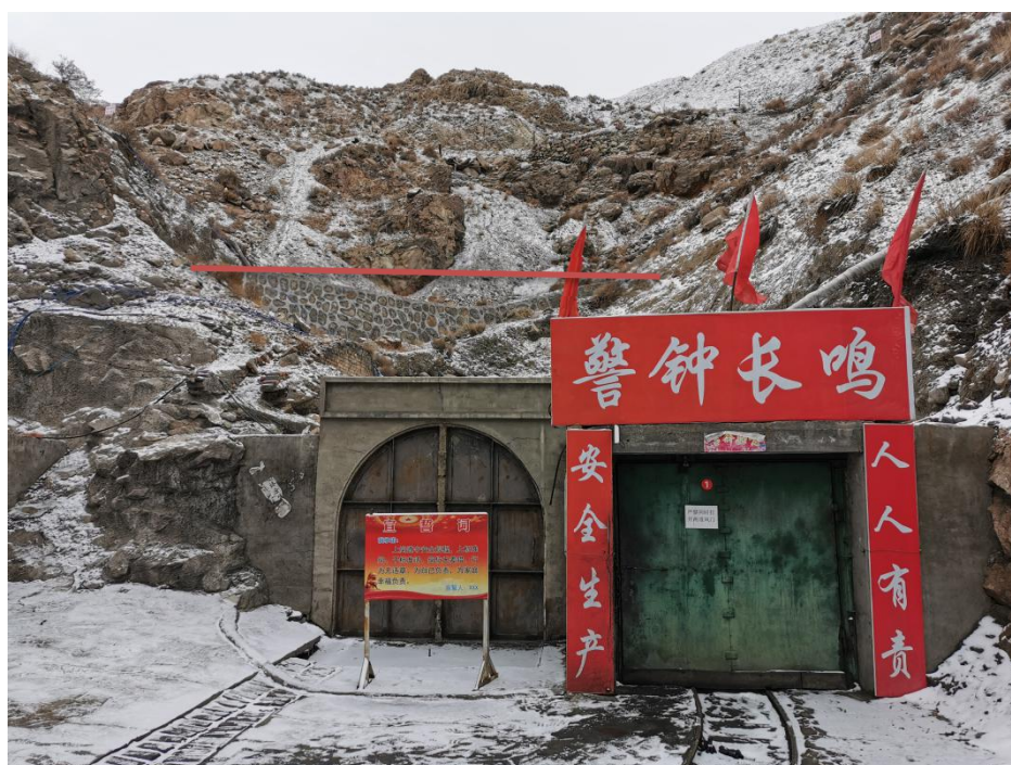
照片 3.2-2 不稳定斜坡 Q 2
