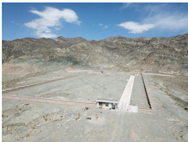
照片 1.3-13 矿炸药库 镜向 EN （5）尾矿库工程
