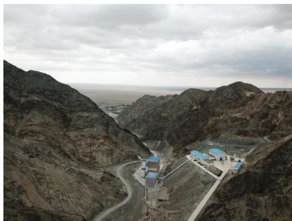
照片 3.3-2 副井工业场地压占土地（镜像 W）
