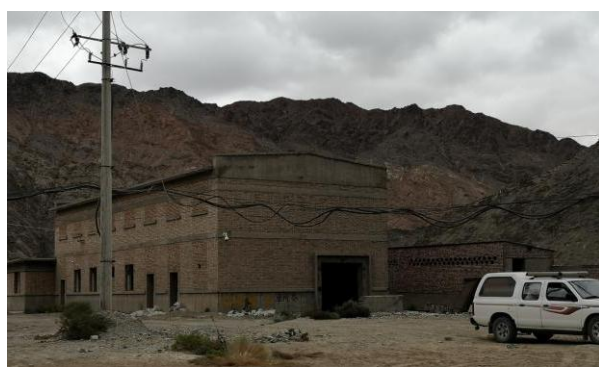
照片 1.3-23 临用建筑物 2 镜向 N 2、地面工程总占地面积
