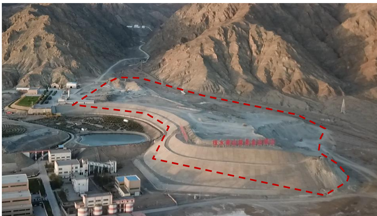
照片 1.3-12 堆渣场 镜向 EN
