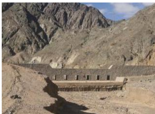
照片 3.2-4 锡铁山沟已建拦挡坝（镜像 E）
