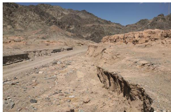
照片 3.2-9 中间沟口已被冲毁排导渠（镜像 E）
