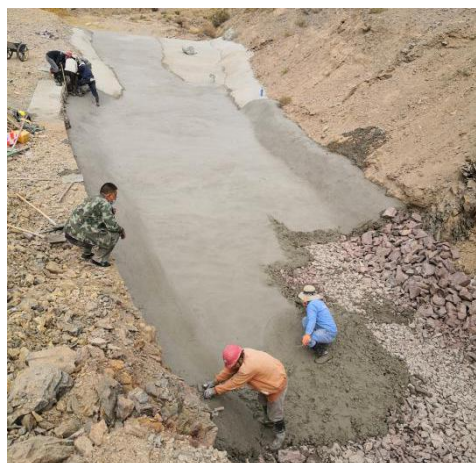
照片 3.2-10 TX3 塌陷区局部施工照片 (镜向 ES)
