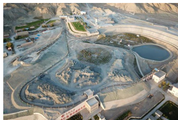
照片 2.6-7 III 号排渣场治理后 镜像 N
