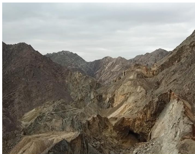
照片 3.2-10 TX3 塌陷区照片 (镜向 E)
