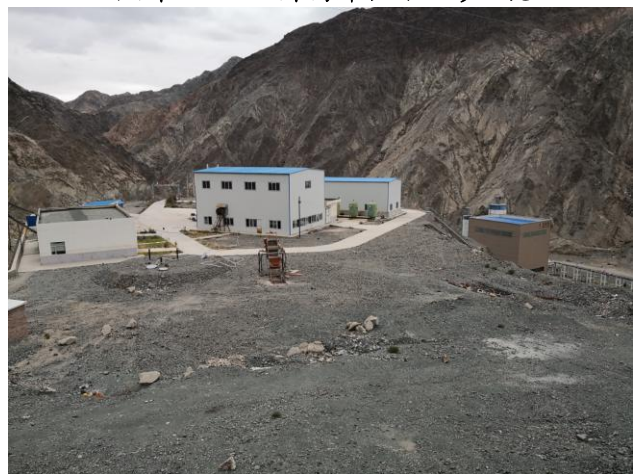
照片 3.2-16 副井工业场地破坏地形地貌
