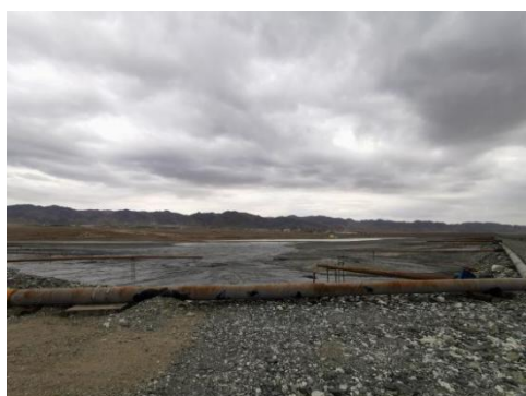
照片 2.6-1 新建尾矿库
