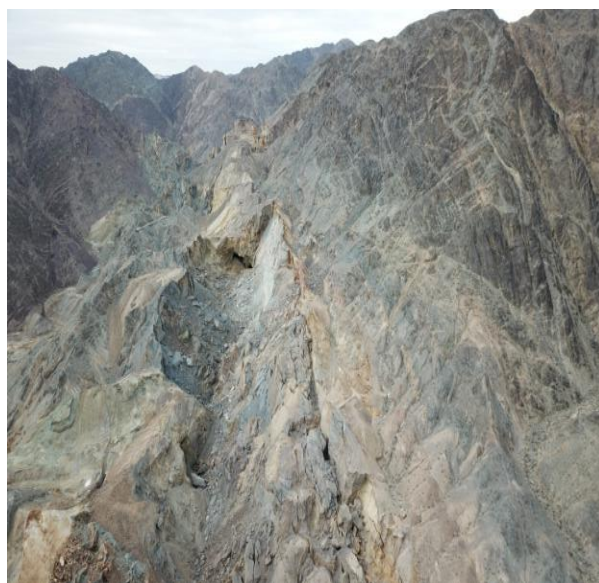
照片 3.2-10 TX2 塌陷区照片（镜向 ES）
