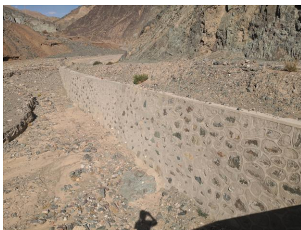
照片 3.2-5 锡铁山沟已建排导渠（镜像 E）
