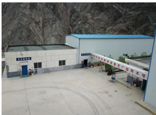
照片 1.3-5 副井工业场地 镜向 N
