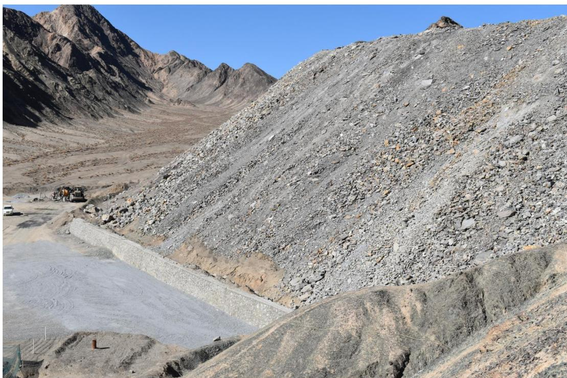
照片 3-4 不稳定斜坡 Q<sub>3</sub>（北矿段西排土场现已修筑浆砌石挡墙）
