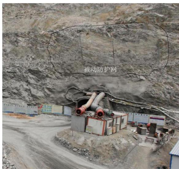
图 3-14 主斜坡道口及防护网
