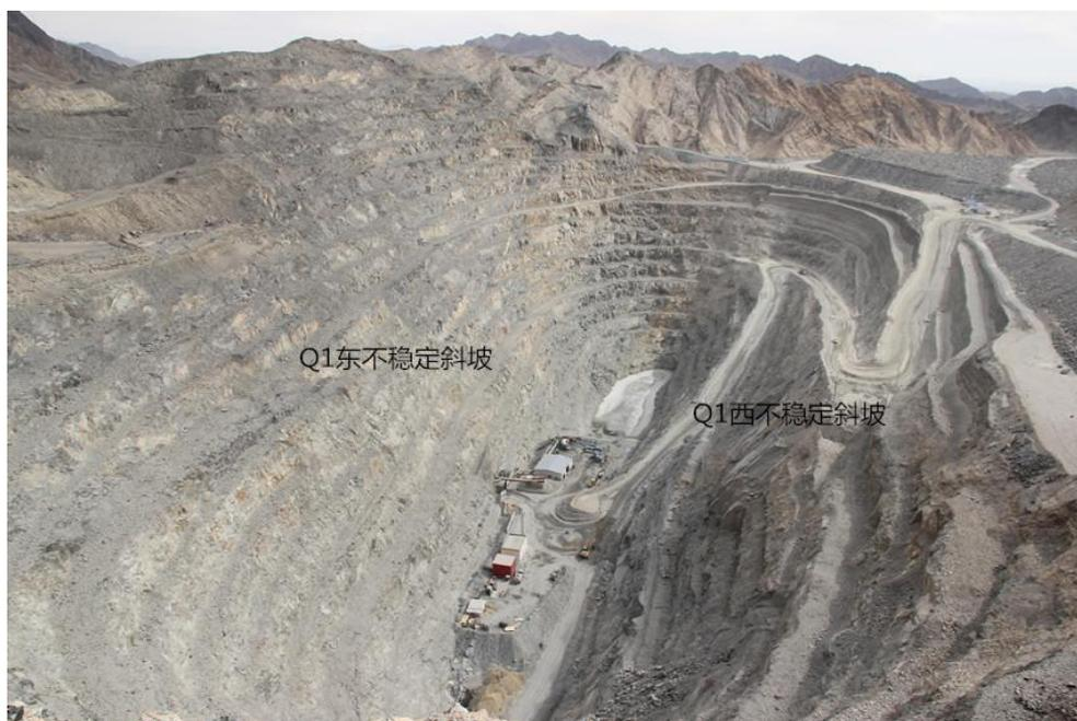
照片 3-1 露天采坑不稳定斜坡（镜向东南）
