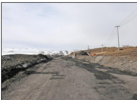
照片 1-7 矿区已有道路
