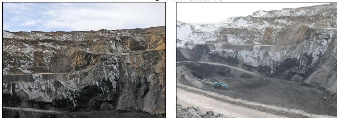
照片 3-2 Q 2 不稳定斜坡照片
