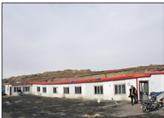
照片 1-6 矿区已有生活区
