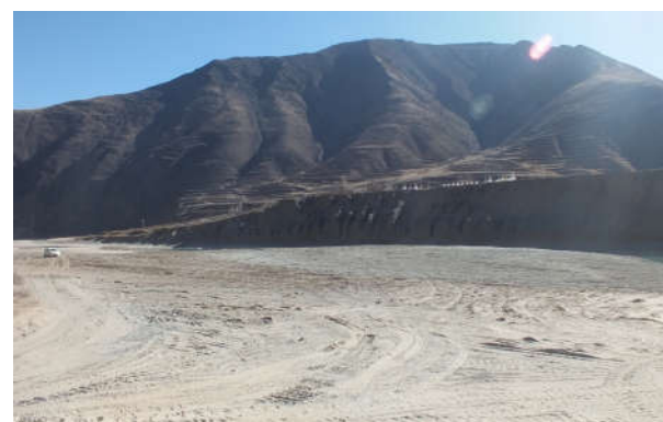
通天河沿岸 47#废弃采砂场治理后
