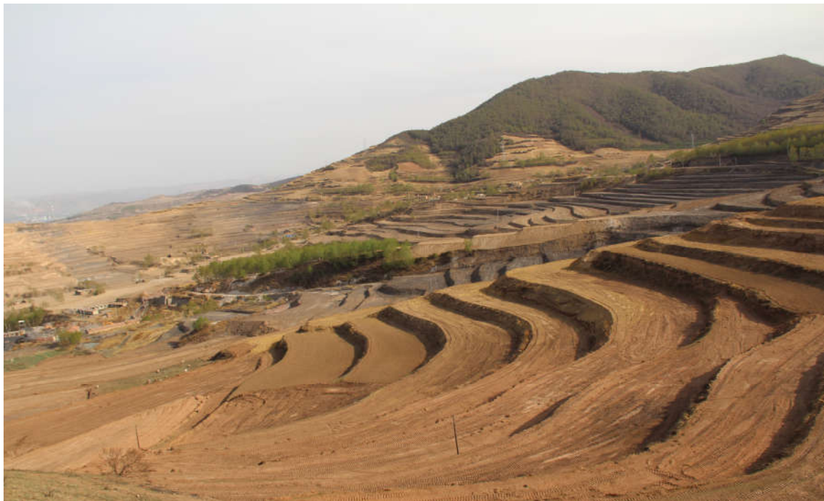
大通煤矿地质环境治理示范工程煤洞沟片区土地平整工程完工后效果
