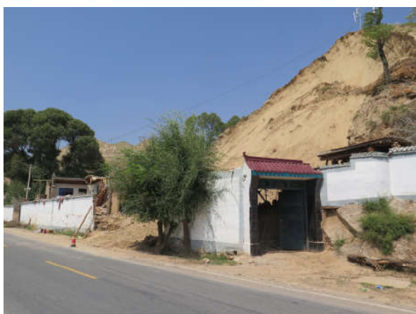
化隆县甘都镇拉目村滑坡
