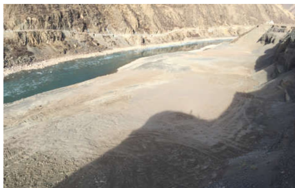
通天河沿岸 30#废弃采砂场治理后
