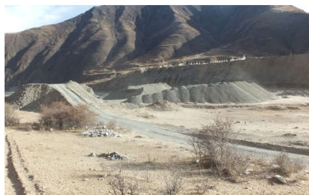
通天河沿岸 47#废弃采砂场治理前
