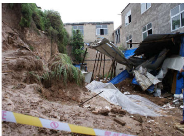
西宁市城中区总寨镇元堡子村滑坡
