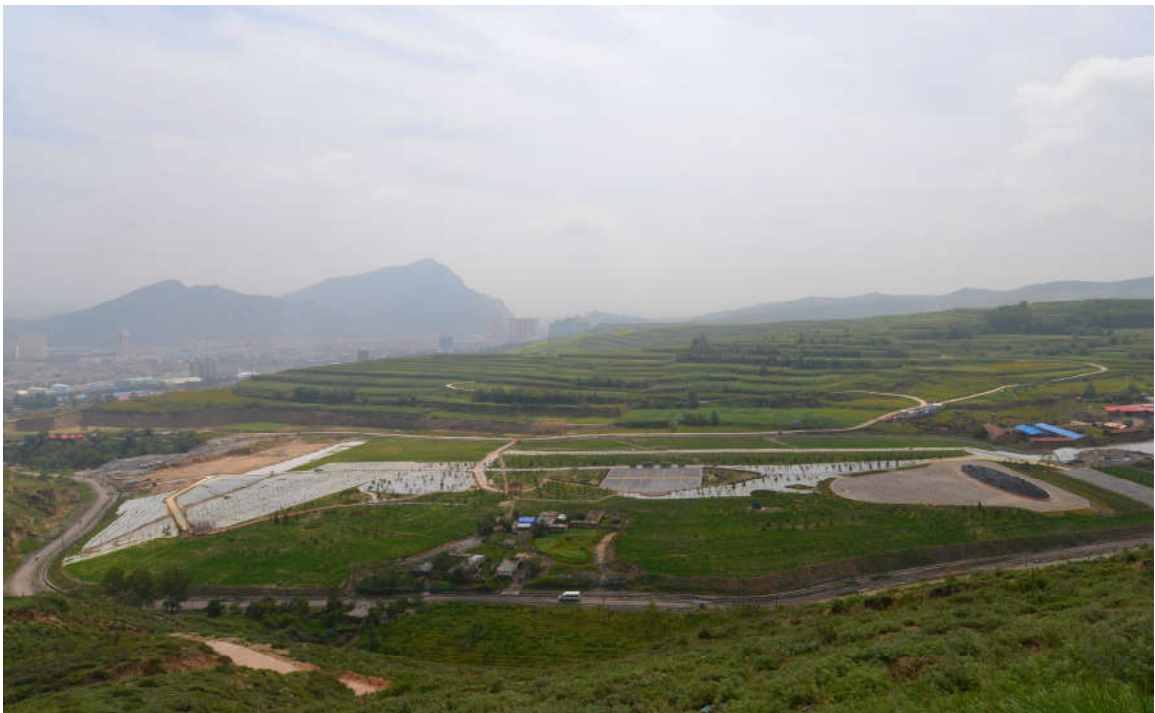
大通小煤洞渣堆治理后景观区全景
