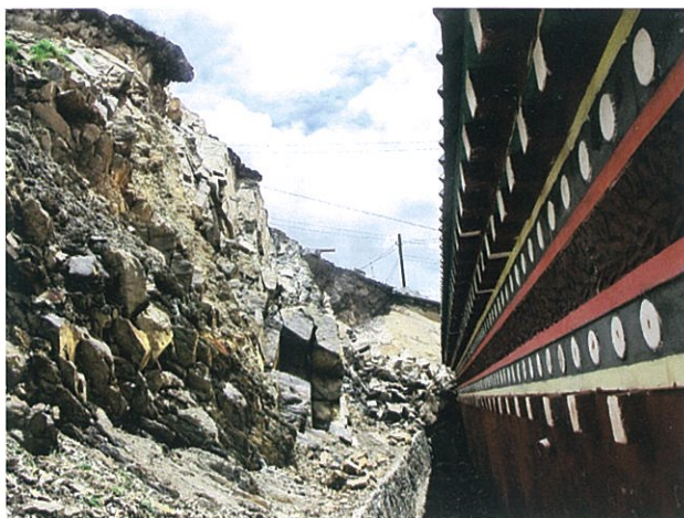
达日县东日寺不稳定斜坡挡墙治理前
