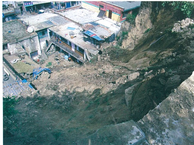
湟中县鲁沙尔镇塔尔湾村滑坡威胁房屋
