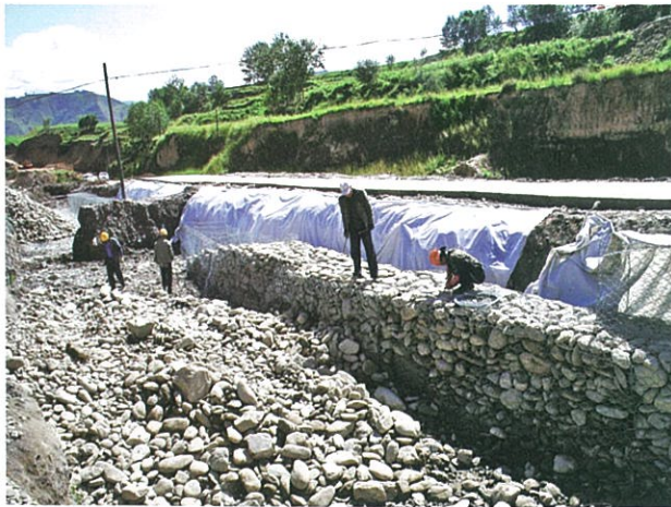
格滨网箱基础施工
