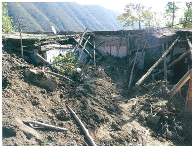
湟中县丹麻乡上洛麻村滑坡毁坏房屋
