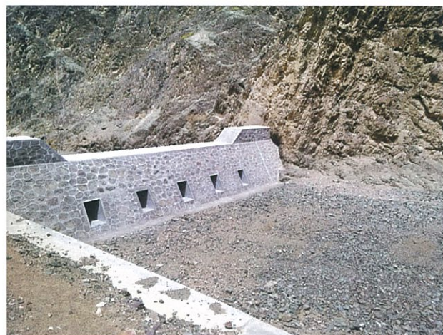
大柴旦行委锡铁山泥石流拦挡坝防治工程
