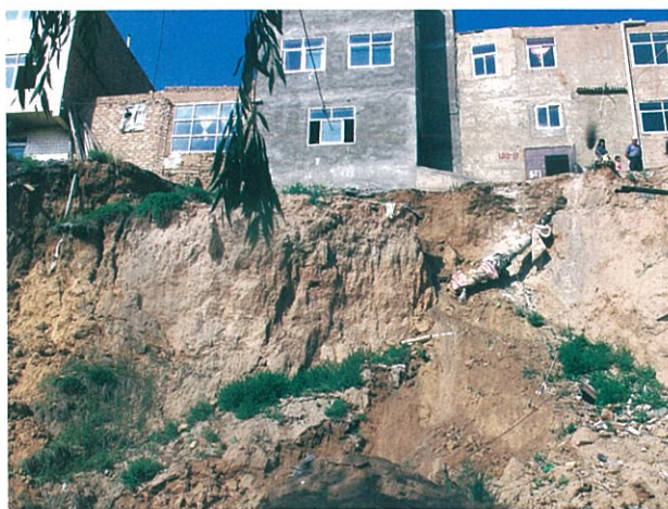
西宁市城中区苦水沟滑坡失稳损毁房屋
