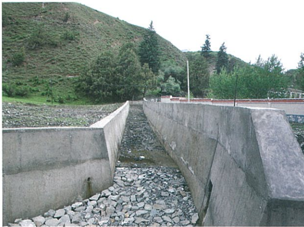
泽库县麦秀镇热藏龙哇沟左侧沟治理工程
