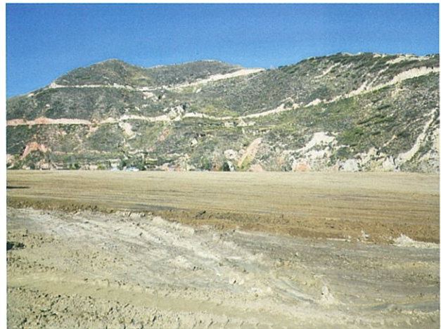
大通县小煤洞渣堆治理后
