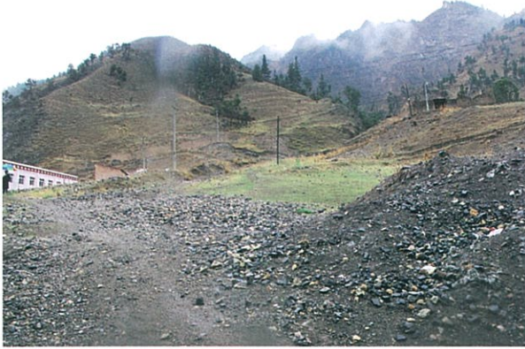
泽库县麦秀镇龙藏沟泥石流沟治理前
