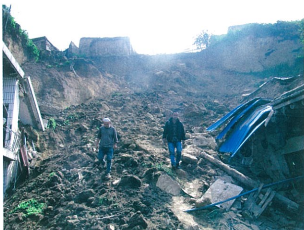
湟中县鲁沙尔镇塔尔湾村滑坡损毁房屋
