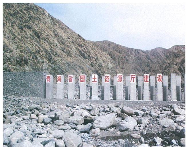
大柴旦行委温泉沟泥石流梳齿坝治理工程
