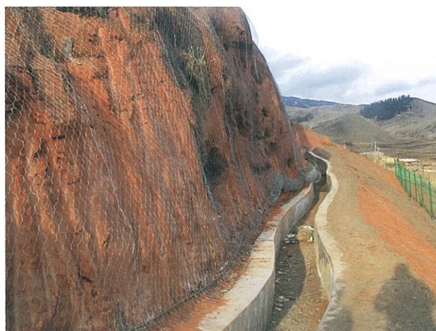
祁连县卡力岗村后山防护网和排导工程
