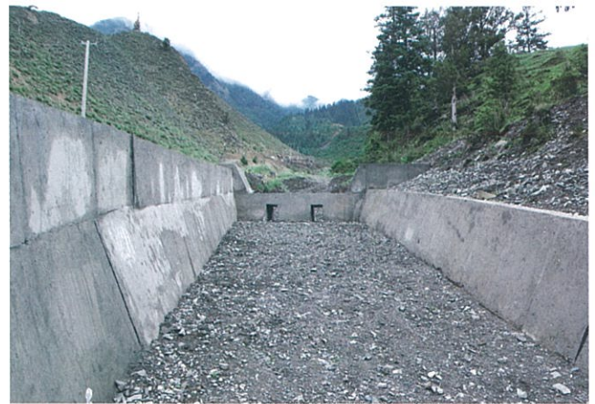
泽库县麦秀镇龙藏沟泥石流拦挡坝工程
