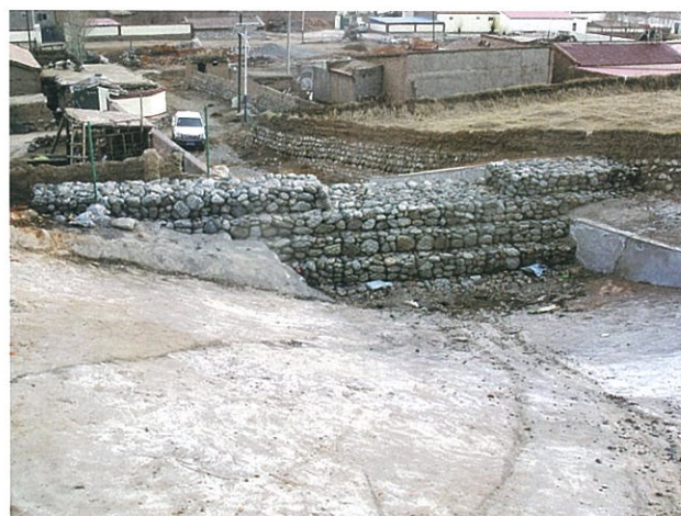
祁连县卡力岗村后山坡面防护和拦挡工程
