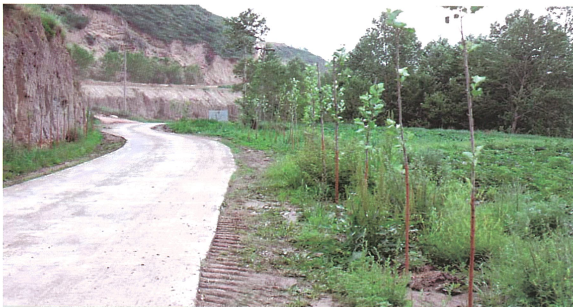
实施后的硬化田间道路和防护林网
