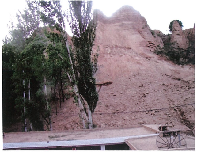
民和县官亭镇鲍家村崩塌
