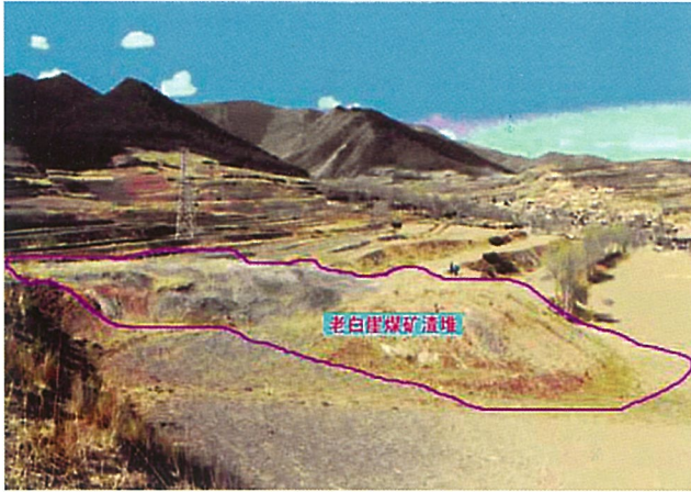
老白崖煤矿渣堆治理前
