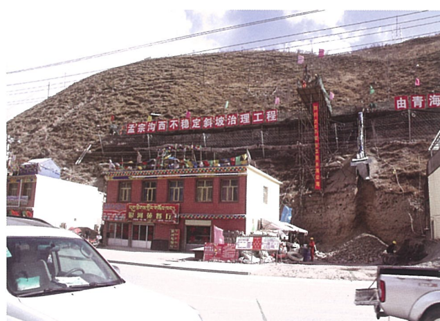
不稳定斜坡治理
